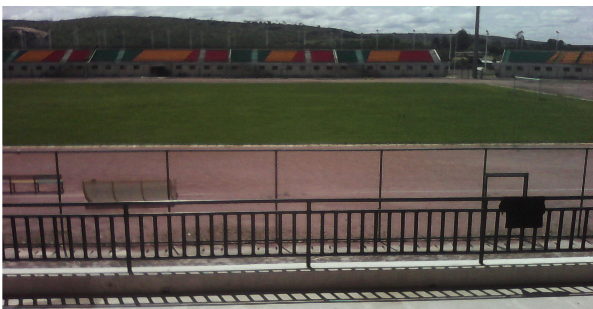
PHOTO-2 : Vue intérieur du Stade Omnisport de Kinkala
